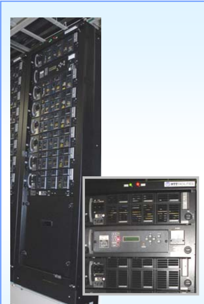
図3 高電圧直流給電用整流装置 プロトタイプ試作機(Aタイプ) N+1ユニット冗長方式 100kW定格出力
