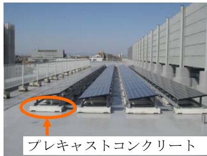
図3. 置き式架台『防水工事が不要で設置がスピーディ』
